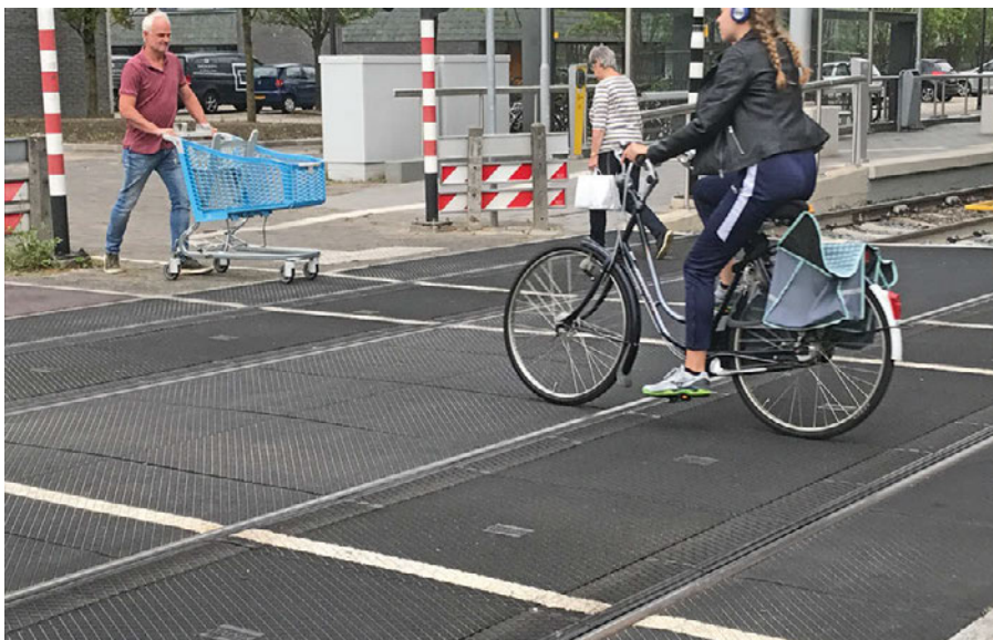
1: Beim barrierefreien Bahnübergangssystem veloSTRAIL wird ein Gummi-Wechselteil zwischen Schiene und Innenplatte eingesetzt und so die Spurrille geschlossen Quelle aller Bilder: KRAIBURG STRAIL GmbH & Co. KG
