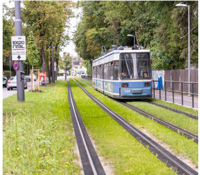
7: Im Sommer 2023 wurden in München 1,8 km Rasengleis verlegt
