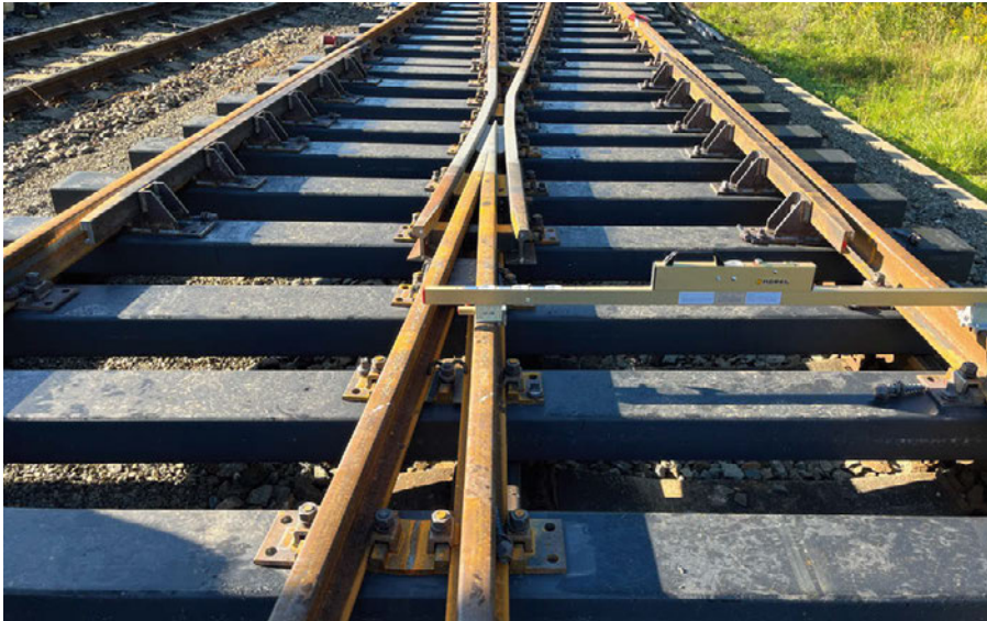
3: Die Kunststoffschwelle STRAILway 30 ist für eine Achslast von 16 Tonnen sowie für die auf Nahverkehrsstrecken übliche maximale Zuggeschwindigkeit von 120 km/h ausgelegt
