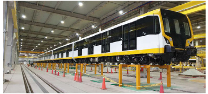
6: Unterflurhubanlage für schwere Züge bis 120 m
