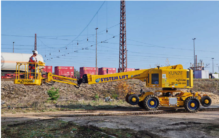
5: RR19 für umfangreiche Bau- und Wartungsarbeiten
