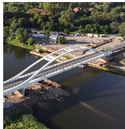
Die erste Netzwerkbogenbrücke mit Carbonhängern
