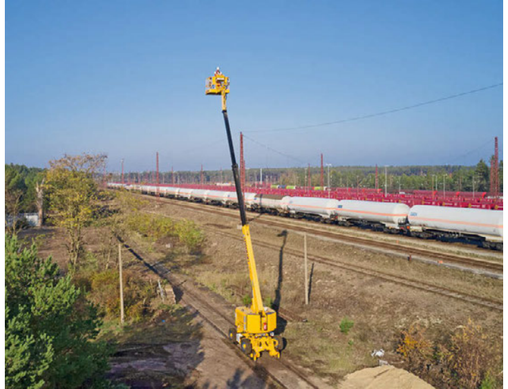
4: RR19 – die derzeit höchste selbstfahrende Arbeitsbühne auf dem Gleis
