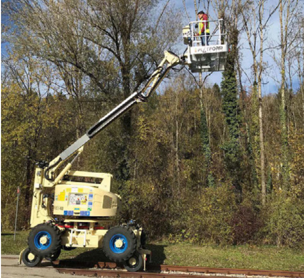
3: RR14 mit Arbeitshöhe bis zu 14,4 Metern
