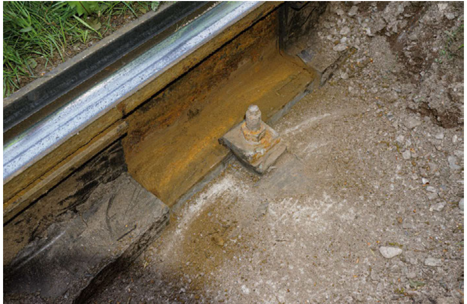
1: Das zu untersuchende Schienenbefestigungssystem nach der Freilegung der Raseneindeckung und Gummiummantelung
