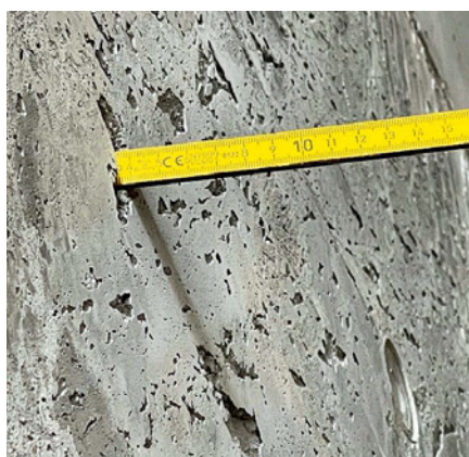
1: Mangelhafte Betonage
