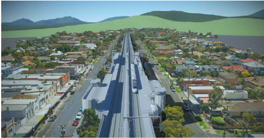
1: Das Parkdale-Projekt ist Teil des staatlichen Programms von Victoria zur Entfernung von schienen- gleichen Bahnübergängen in Melbourne, um die Sicherheit, Reisezeiten und Verkehrsanbindung zu verbessern Quelle/Bildgenehmigung durch WSP Australia Pty. Ltd.
