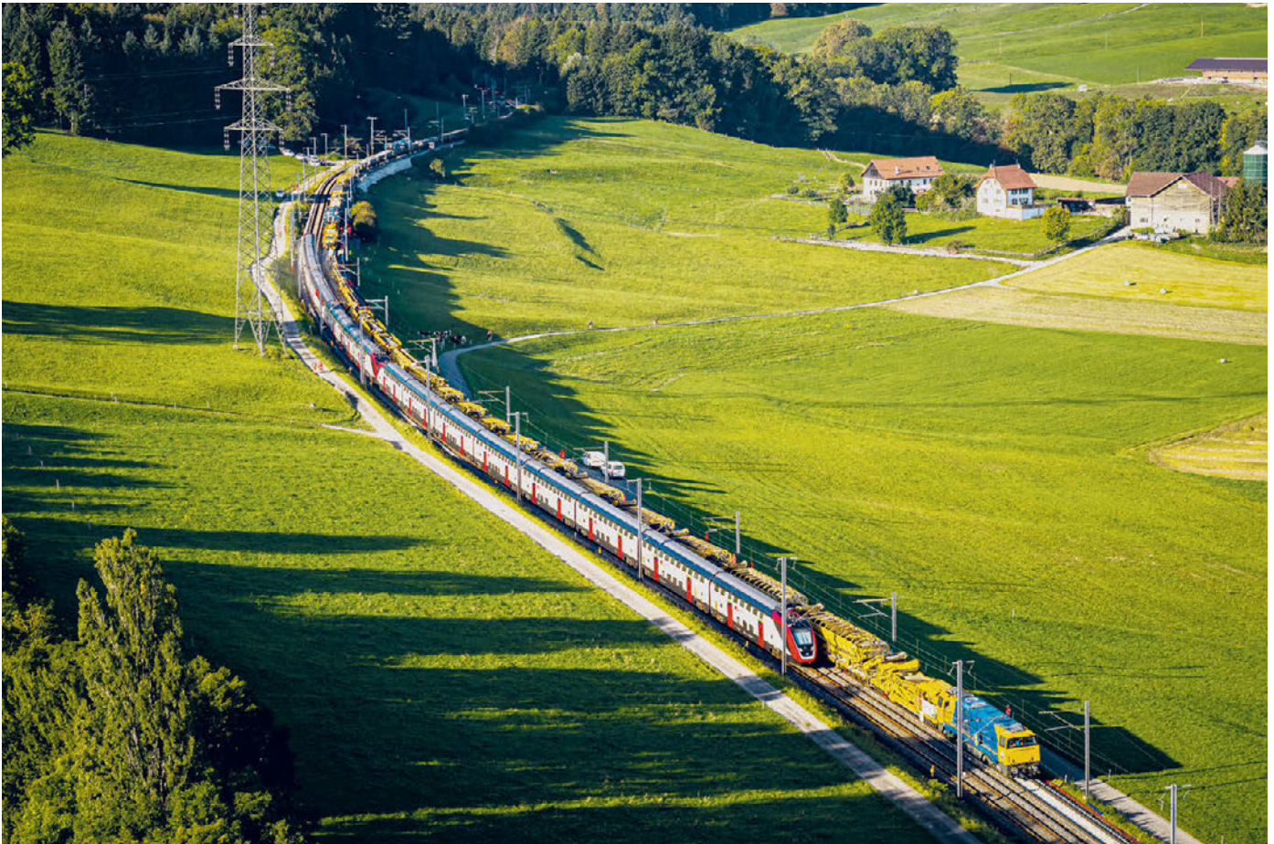
Abb. 1: Gleisarbeiten in Palézieux, Kanton Waadt
